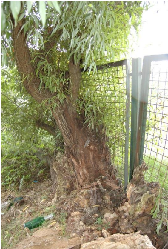
Il.8. Przykład wrośnięcia pnia drzewa w ogrodzenie.
